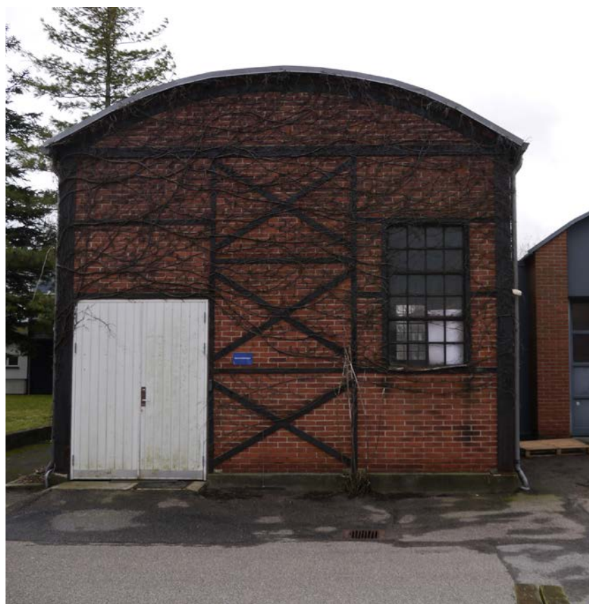
BYGNINGSREGISTRERING | TOGVOGNEN TV: TOGVOGNEN UDEFRA MED KARAKTERISTISK STÅLBINDINGSVÆRK OG FACADE I RØDE MURSTEN, SAMT ORIGINALE SPROSSEDE STÅLVINDUER TH: TOGVOGNEN INDEFRA MED SYNLIG, SPINKEL STÅLTAGKONSTRUKTION OG HØJTSIDDEDE VINDUER
