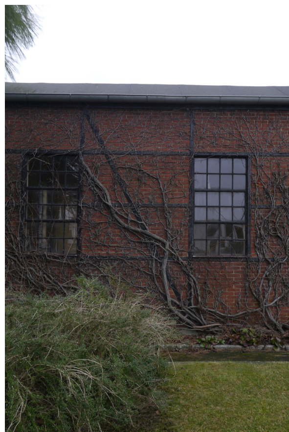
BYGNINGSREGISTRERING | TOGVOGNEN TV: TOGVOGNEN UDEFRA MED KARAKTERISTISK STÅLBINDINGSVÆRK OG FACADE I RØDE MURSTEN, SAMT ORIGINALE SPROSSEDE STÅLVINDUER TH: TOGVOGNEN INDEFRA MED SYNLIG, SPINKEL STÅLTAGKONSTRUKTION OG HØJTSIDDEDE VINDUER
