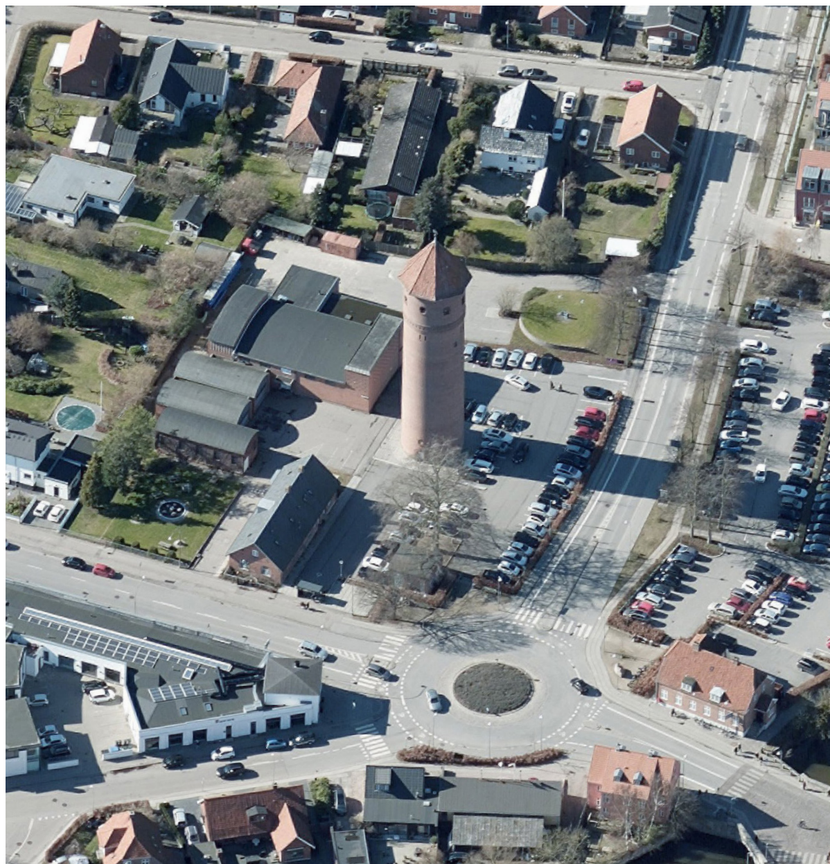
KØGE VANDVÆRK | LUFTFOTO | 2017
